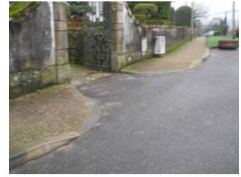
Rebaixamento para veículos mal desenhado Trecho n.º 151
