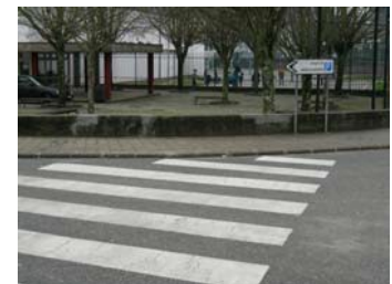
Inexistência de Rebaixamento Trecho n.º 90
