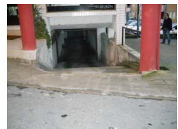
Rebaixamento para veículos mal desenhado Trecho n.º 27
