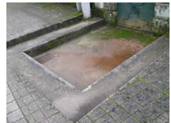
Escadas de acesso a casa Trecho n.º 11
