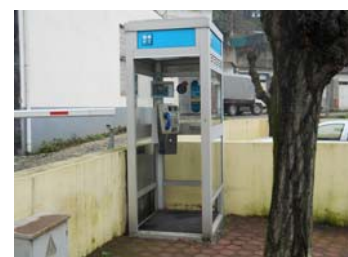
Cabine Telefónica mal desenhada Trecho n.º 100
