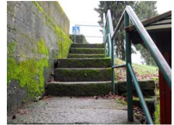
Escadas Urbanas Trecho n.º 163
