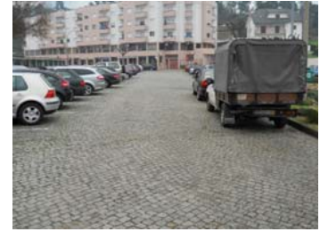
Parque de Estacionamento Trecho n.º 80
