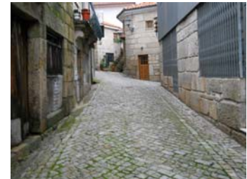
Rua de largura < 5,40m Trecho n.º 128
