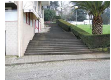
Escadas Urbanas Trecho n.º 700
