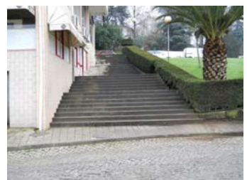
Escadas urbanas Trecho n.º 700
