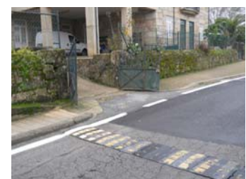
Rebaixamento para veículos mal desenhado EN 304 – Trecho n.º 75
