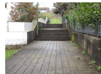
Escadas Urbanas Trecho n.º 60
