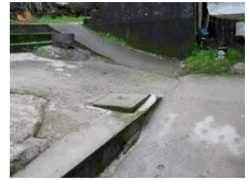
Rampa Trecho n.º 210
