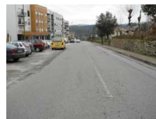
Rua Urbanizada Trecho n.º 6
