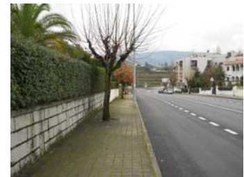
Rua de largura > 6m Trecho n.º 49
