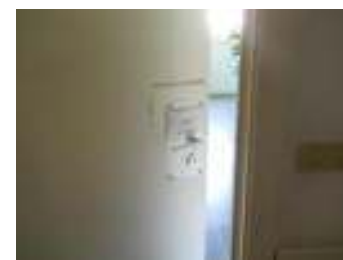
FIG. 13 - Porta tipo do edifício
