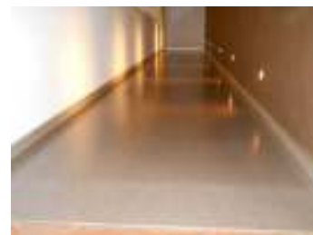
FIG. 13 - Rampa de acesso ao espaço de exposições
