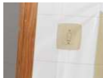
FIG. 33 - Interruptor do edifício
