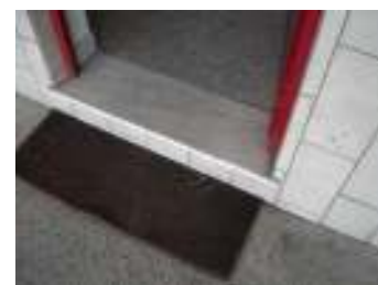
FIG. 16 - Acesso ao interior
