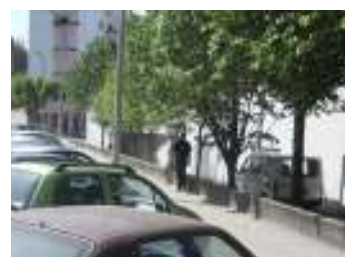
FIG. 5 - Muro de vedação do recinto
