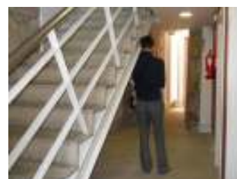
Pé direito inferior a 2 m no vão de uma escada da Câmara
