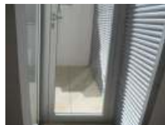
FIG. 9 - Mecanismo de abertura demasiado alto.
