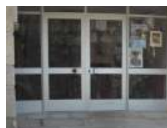
FIG. 15 - Porta de acesso ao edifício
