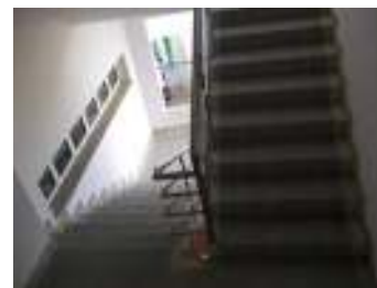
FIG. 12 - Escadas de acesso ao recinto
