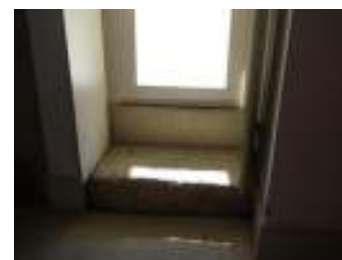
FIG. 26 - Detalhe dos degraus de acesso à porta
