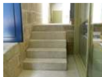
FIG. 45 - Primeiro lanço das escadas de acesso ao piso 1 junto aos gabinetes
