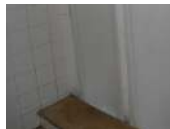
FIG. 34 -Degraus de acesso aos urinóis
