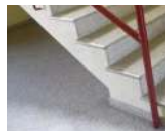
FIG. 37 - Espaço vazado das escadas de acesso ao piso 1
