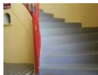
FIG. 20 - Detalhe do patamar inferior das escadas
