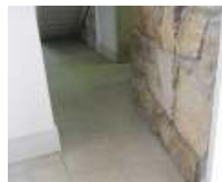
FIG. 44 - Rampa de acesso a gabinetes do piso 0
