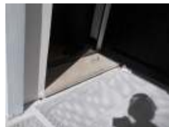
FIG. 18 - Porta de acesso ao recinto com ressalto
