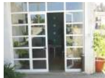
FIG. 7 - Acesso desnivelado ao interior.
