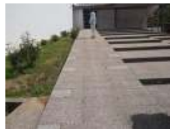
FIG.17 - Rampa no recinto
