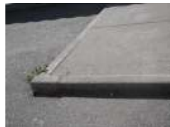
FIG. 13 - Ressalto junto ao Bloco E
