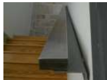
FIG. 47 - Segundo lanço das escadas de acesso ao piso 1
