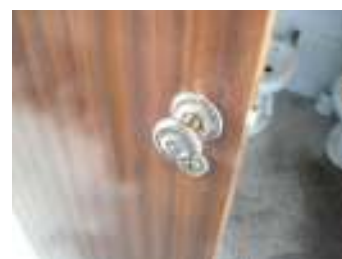
Puxador do tipo maçaneta na Central de Camionagem
