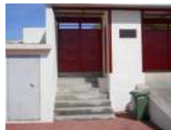
FIG. 7 - Escadas de acesso ao recinto
