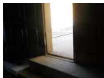
FIG. 9 - Porta de acesso ao vestíbulo
