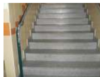
FIG. 28 - Escada de acesso ao 1º piso do Blocos E
