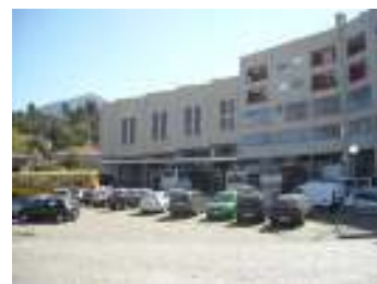
FIG. 1 - Alçado Principal da Central de Camionagem.
