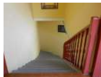
FIG. 20 - Vista superior das escadas
