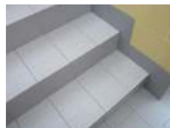
FIG. 24 - Degraus sem faixa contrastante
