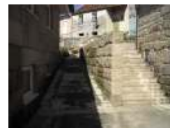
FIG.4 - Escadas sem sinalização e corrimãos
