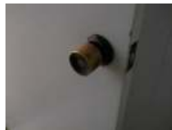
FIG. 21 - Porta de acesso à sala de convívio
