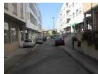
FIG. 3 - Via contígua ao edifício
