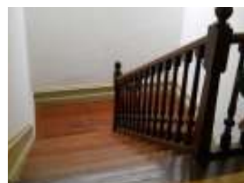
FIG. 49 - Escadas de acesso ao piso 1 no edifício antigo
