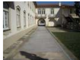
FIG.2 - Edifício não sinalizado
