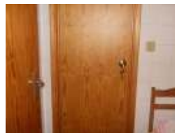
FIG. 16 - Porta de acesso a instalações sanitárias
