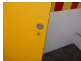
FIG. 29 - Porta de acesso à IS para PMC
