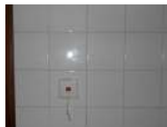
FIG. 33 - Alarme na instalação sanitária alternativa para PMC
