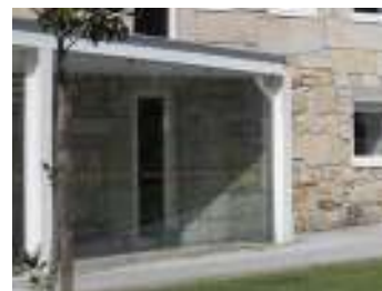
FIG. 32 - Vista exterior da antecâmara de acesso ao turismo
