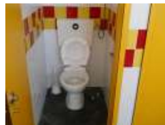
FIG. 33 - Porta de acesso à IS e mecanismo inacessível da sanita
