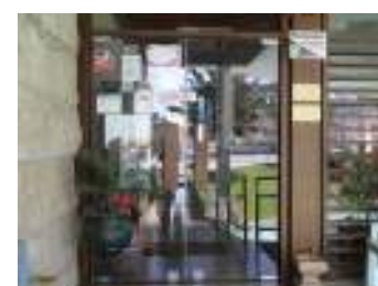
FIG. 6 - Porta de acesso ao interior do edifício.
