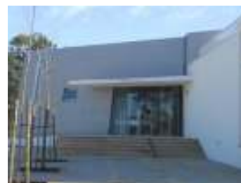
FIG. 2 - Fachada principal sem identificação
