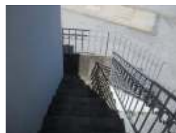
FIG. 15 - Escadas de acesso ao piso 1
