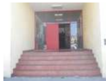
FIG. 6 - Escadas de acesso ao patamar de entrada do edifício
