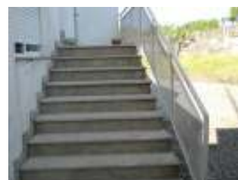
FIG. 10 - Degraus com focinho saliente e corrimão unilateral
