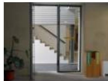
FIG. 37 - Porta dupla de vidro de acesso à recepção no piso 0
