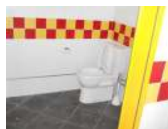
Instalações sanitárias (IS) adaptadas do Estádio Municipal
