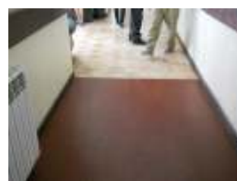
Rampa de acesso a quartos no Lar da Santa Casa da Misericórdia
