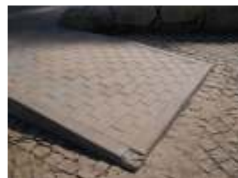
FIG. 4 - Rampa de acesso ao edifício
