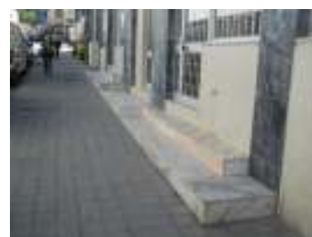
FIG. 9 - Detalhe das escadas da entrada para as finanças
