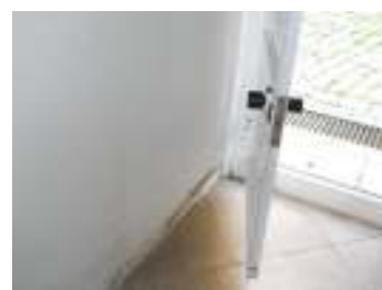
FIG. 20 - Porta de acesso ao vestíbulo da igreja
