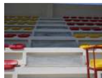
FIG. 21 - Escada de acesso às bancadas
