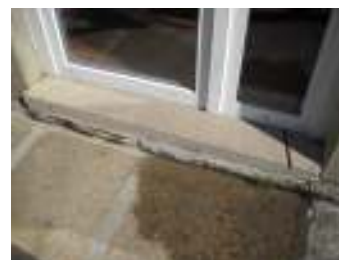
FIG.7 - Porta de acesso com ressalto
