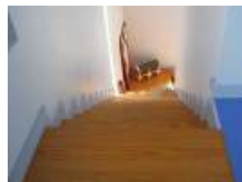
FIG. 9 - patamares e degraus sem sinalização
