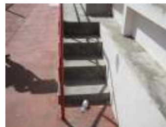
FIG. 22 - Escada de acesso às bancadas
