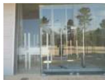
FIG. 8 - Porta de acesso ao vestíbulo da Biblioteca
