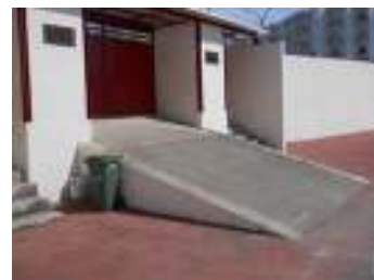
FIG. 8 - Rampa de acesso ao recinto
