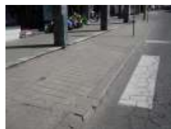
FIG. 5 - Passeio sem faixas de encamihamento e de alerta
