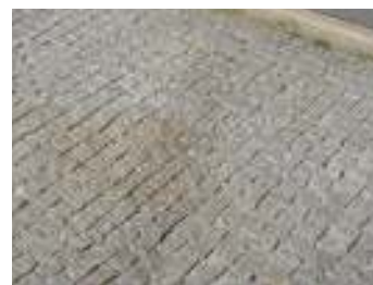
FIG.7 - Pavimento não acessível
