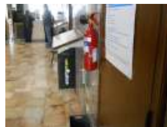
FIG. 26 - Extintor saliente na sala de espera
