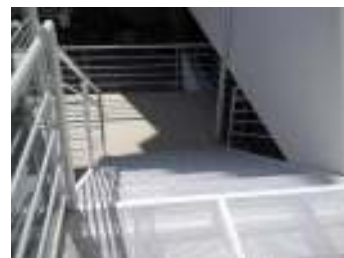
FIG. 11 - Escadas de acesso ao recinto
