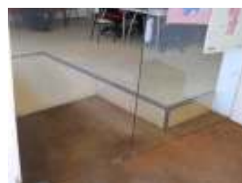
FIG. 10 - Detalhe da superfície envidraçada
