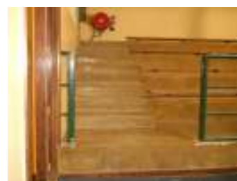
FIG. 39 - Escadas de acesso às bancadas
