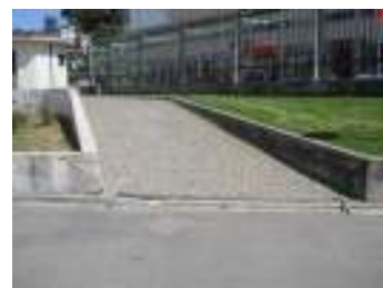
FIG. 8 - Rampa de acesso ao recinto
