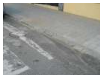
FIG. 4 - Passadeira com ressalto junto ao edifício das Finanças
