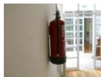
FIG. 20 - Extintor saliente
