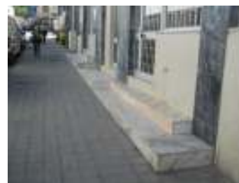
Degraus compensados no acesso às Finanças
