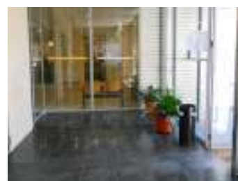
FIG. 31 - Vista interior da antecâmara de acesso principal ao edifício
