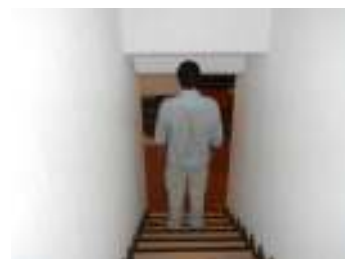
FIG. 28 - Degraus com altura inferior a 2m
