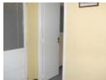
FIG. 17 - Porta de acesso a gabinetes
