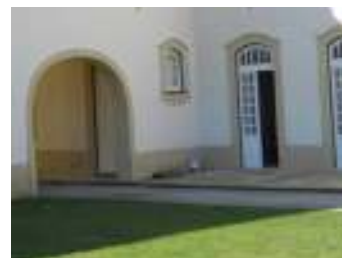
FIG. 8 - Passeio de acesso aos gabinetes técnicos
