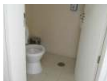
FIG. 60 - Porta de acesso à cabine
