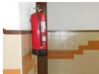
FIG. 49 - Extintor saliente
