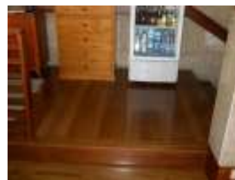
FIG. 6 - Degrau isolado no interior.
