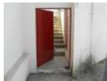
FIG. 9 - Ressalto no acesso secundário ao interior
