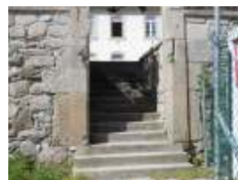
FIG. 13 - Escadas de acesso ao piso -1
