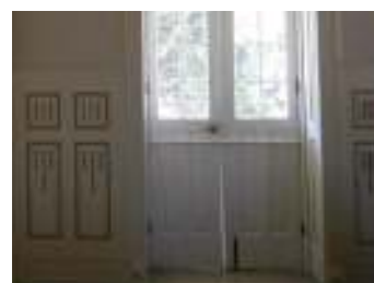
FIG. 24 - Perspectiva interior da porta de acesso ao salão
