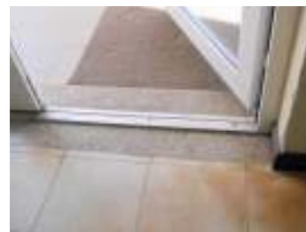
FIG. 17 - Porta de acesso ao recinto
