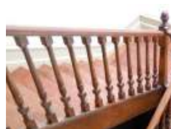
Comunicação vertical na Câmara Municipal
