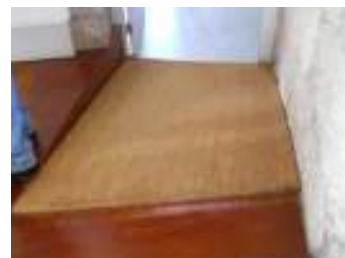
FIG. 43 - Rampa de acesso a gabinetes do piso 1
