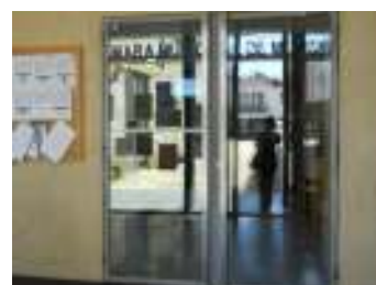
FIG. 30 - Porta da antecâmara de acesso principal ao edifício
