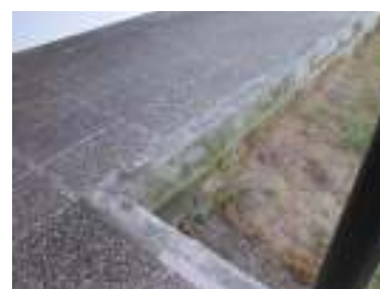
FIG. 14 - Ressalto junto ao edifício
