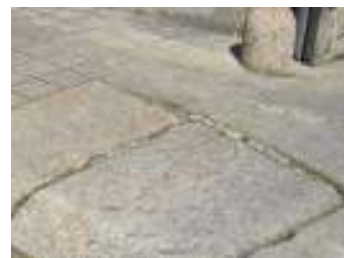
FIG. 8 - Revestimento do passeio envolvente
