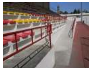
FIG. 28 - Rampa de acesso à bancada
