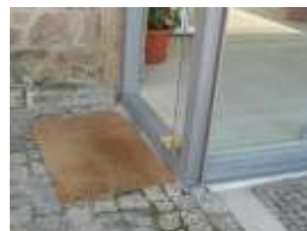
FIG. 6 - Ressonância no acesso ao edifício
