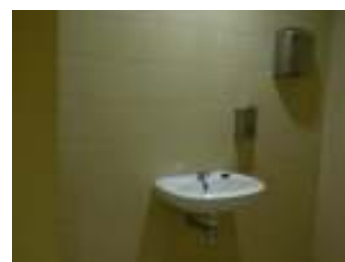
IS adaptadas com torneiras e acessórios inacessíveis
