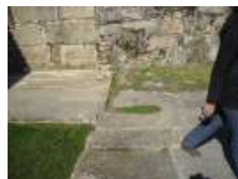
FIG.3 - Pavimento não acessível
