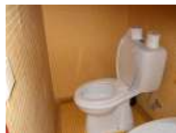
FIG. 30 - Vista do interior da IS de apoio ao palco
