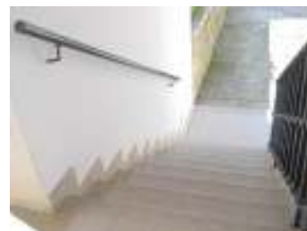
FIG. 10 - Escadas de acesso ao recinto
