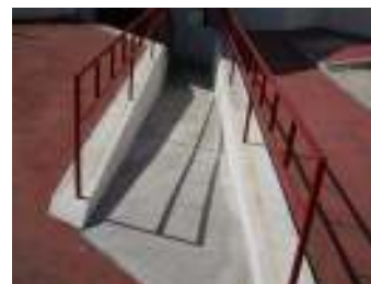
FIG. 27 - Rampa de acesso às IS
