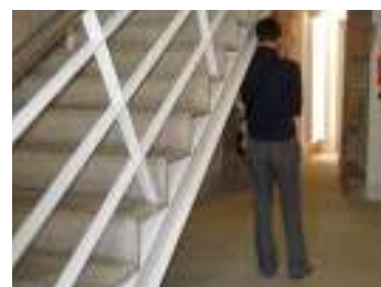
FIG. 51 - Escadas de acesso ao piso 1
