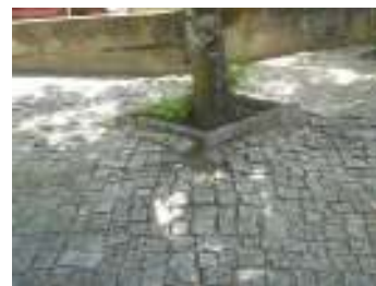
FIG. 7 - Pavimento do Recinto
