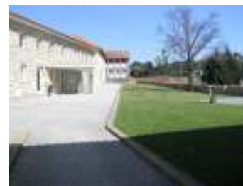
FIG. 7 - Vista do recinto interior
