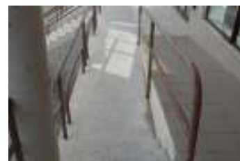
Degraus e rampa no acesso à Segurança Social
