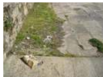
FIG.4 - Pavimento não acessível
