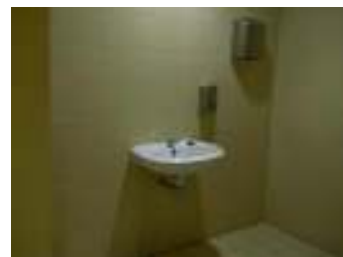
FIG. 21 - Lavatório das instalações sanitárias para PMC
