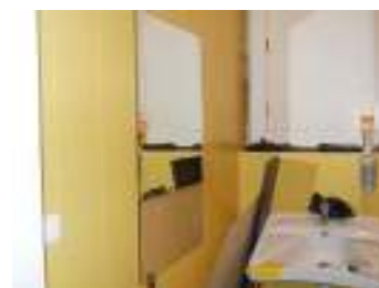
FIG. 58 - Interior da casa de banho para PMC
