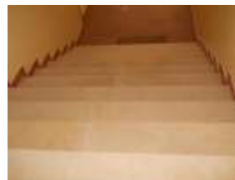
FIG. 41 - Escadas de acesso às bancadas
