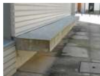
FIG. 5 - Banco junto à entrada principal do Edifício
