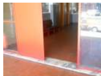
FIG. 10 - Porta de acesso no alçado principal
