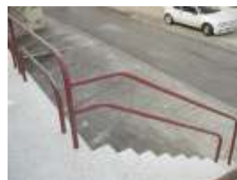
FIG. 8 - Corrimãos das escadas
