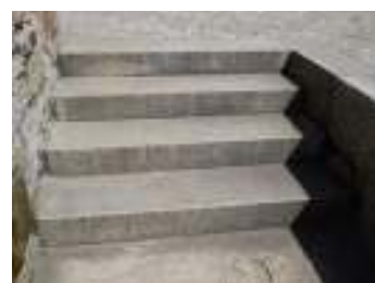
FIG. 16 - Degraus de acesso à Assembleia Geral
