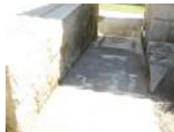
FIG. 17 - Rampa de acesso aos gabinetes técnicos
