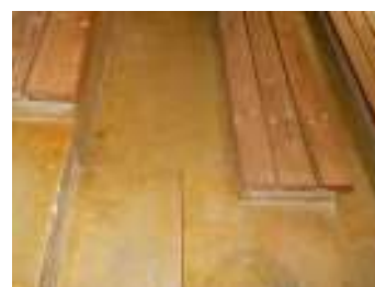
FIG. 40 - Escadas de acesso às bancadas
