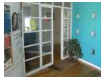
FIG. 12 - Porta dupla com vão insuficiente
