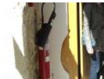
FIG.27 - Extintor é um objecto saliente sem marcação táctil
