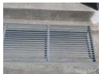
FIG. 7 - Grelha junto às escadas
