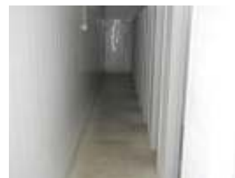
FIG. 16 - Corredor de distribuição no interior do balneário.
