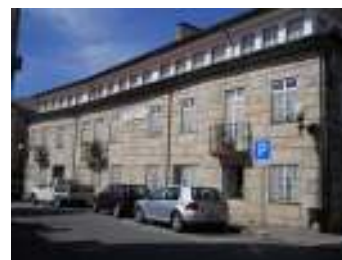
FIG. 1 - Alçado Principal da Santa Casa da Misericórdia
