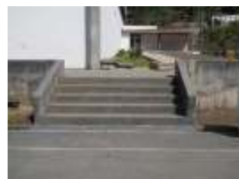
FIG. 10 - Escada de acesso à entrada do Gimnodesportivo
