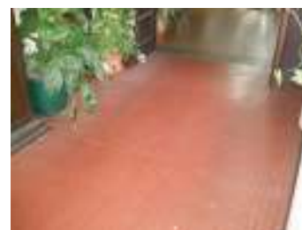
FIG. 26 - Rampa de acesso aos quartos
