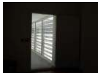
FIG. 34 - Porta de acesso ao passadiço
