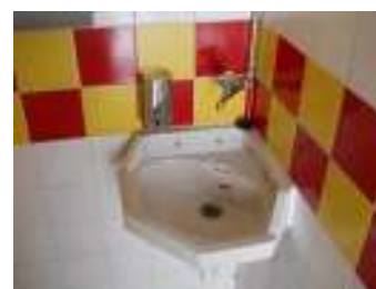
FIG. 35 - Lavatório da IS com mecanismo inacessível
