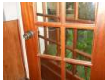
FIG. 22 - Porta de acesso ao corredor
