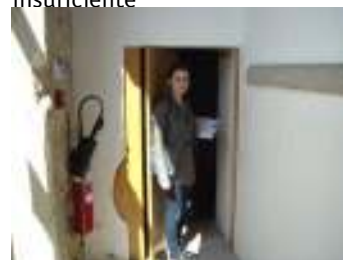
FIG.11 - Porta com vão útil de passagem insuficiente altura inferior a 2m
