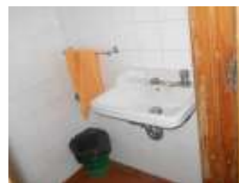
FIG. 26 - Acessórios e mecanismos operáveis inacessíveis
