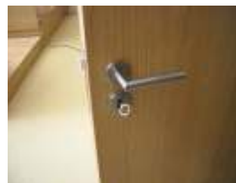
FIG.12 - Porta com vão útil de passagem insuficiente
