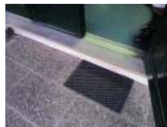
FIG. 17 - Porta de acesso com ressalto
