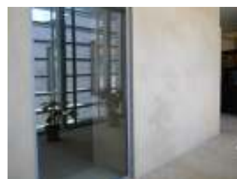
FIG. 41 - Superfície envidraçada sem sinalização
