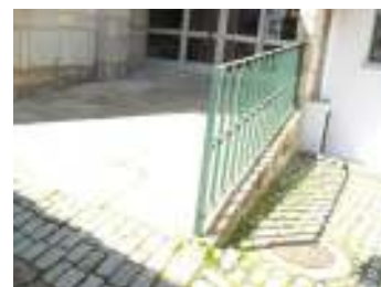
FIG. 6 - Rampa de acesso ao edifício
