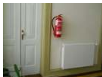
FIG. 80 - Extintor Saliente
