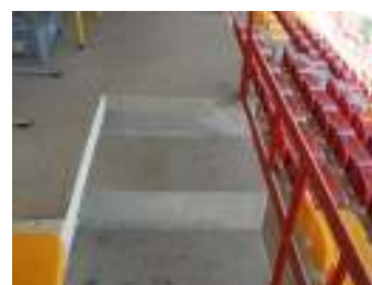
FIG. 25 - Escada de acesso à cabine na bancada
