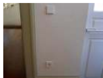
FIG. 76 - Interruptores e tomadas
