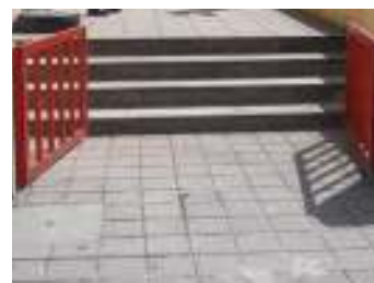
FIG. 8 - Escadas de acesso ao patamar do pavilhão
