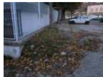
FIG. 8 - Passeio descontinuo
