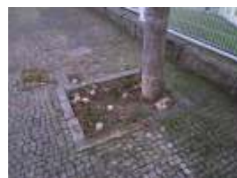
FIG. 6 - Caldeira de árvore sem grelha.
