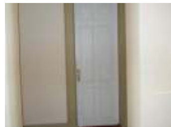
FIG. 33 - Porta de uma folha com vão insuficiente
