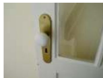
Puxador do tipo maçaneta na Câmara Municipal
