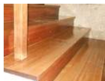
FIG. 10 - Degraus com focinho saliente.
