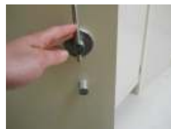
Cabine com mecanismo de abertura inacessível
