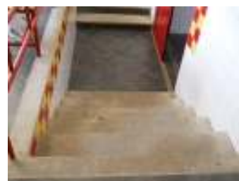
FIG. 24 - Escada de acesso aos balneários
