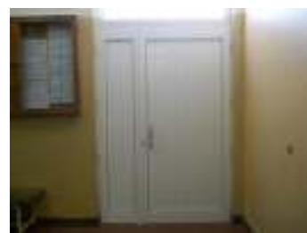
FIG. 26 - Porta de acesso ao recinto
