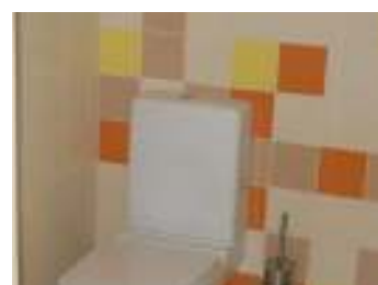
FIG. 15 - Mecanismo de descarga inacessível
