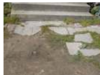
FIG. 9 - Escadas de acesso ao piso -1
