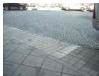
FIG. 3 - Acesso ao edifício
