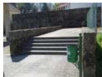
FIG. 18 - Zona junto do estacionamento contíguo ao piso -1
