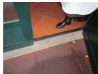
FIG. 18 - Porta de acesso com ressalto
