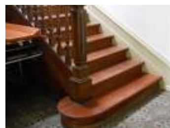
FIG. 50 - Escadas de acesso ao piso 1 no edifício antigo
