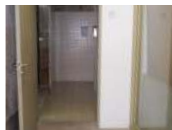
FIG. 59 - Acesso ao WC
