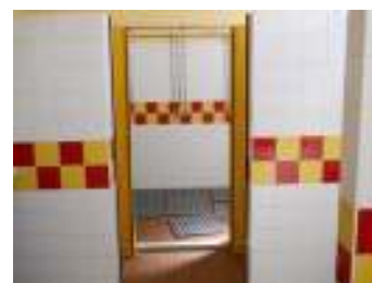
FIG. 39 - Ressalto de acesso à zona de duche
