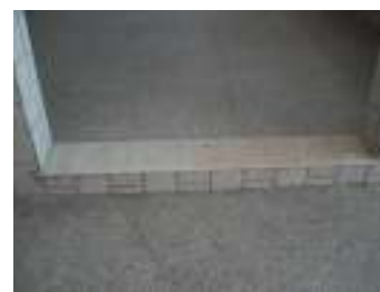
FIG. 10 - Degrau isolado no interior
