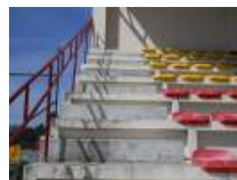
FIG. 19 - Vista das escadas de acesso às bancadas
