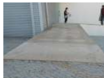
FIG. 5 - Rampa de acesso ao edifício
