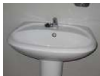
FIG. 20 - Lavatório inacessível
