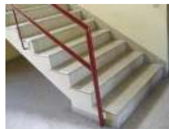
FIG. 22 - Escadas de acesso ao piso 1
