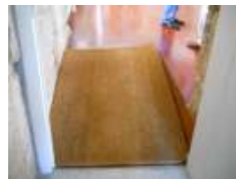
Rampa de acesso a gabinetes na Câmara Municipal
