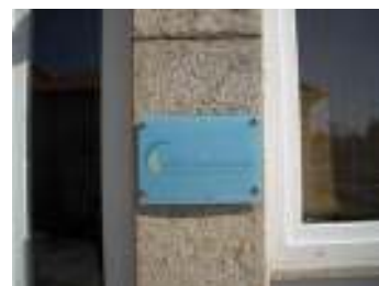
FIG.2 - Sinalização não acessível
