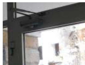
FIG. 16 - Detalhe da porta
