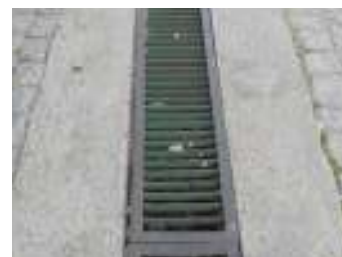
FIG. 14 - Grelha de escoamento
