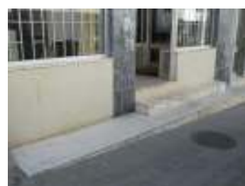
FIG. 10 - Escada de acesso ao edifício
