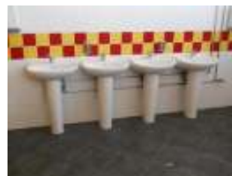
FIG. 34 - Lavatórios de pé e sem espelho
