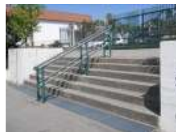
FIG. 6 - Escadas no acesso principal ao recinto
