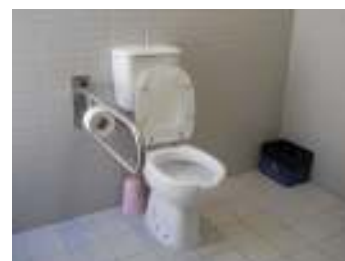
IS adaptadas sem alarme na Câmara Municipal
