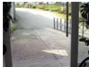
FIG. 7 - Rampa de acesso ao edifício
