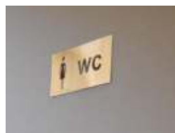
FIG. 22 - Porta de acesso a IS com vão insuficiente
