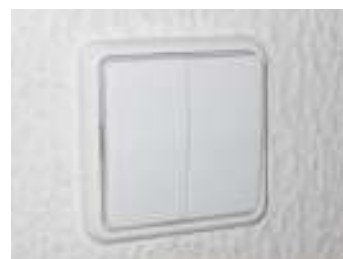
FIG. 39 - Interruptor tipo dos Blocos
