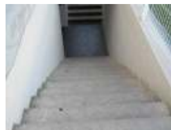
FIG. 23 - Escada de acesso aos balneários
