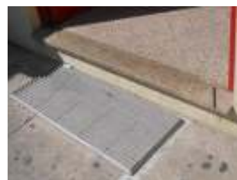
FIG. 36 - Grelha junto à porta de acesso ao vestíbulo do bar
