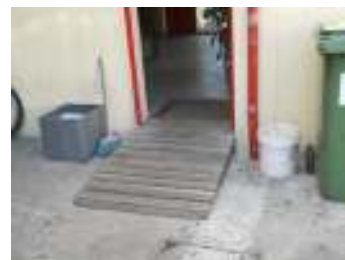
FIG. 15 - Porta de acesso ao vestíbulo junto ao bar
