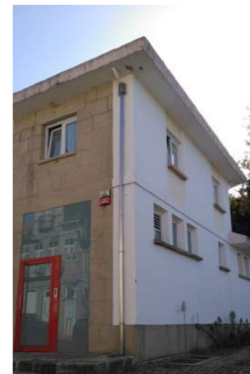
82 | Cobertura com recolha de águas pluviais
