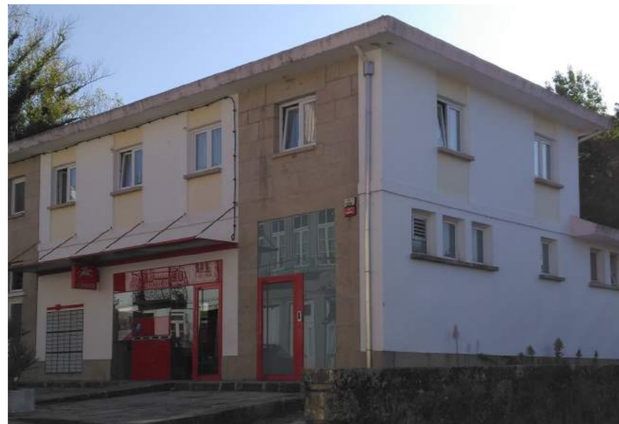
73 | Edifício em bom estado de conservação
