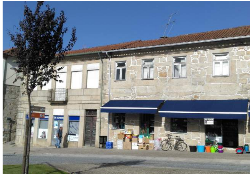
67 | Edifício com comércio no rés do chão
