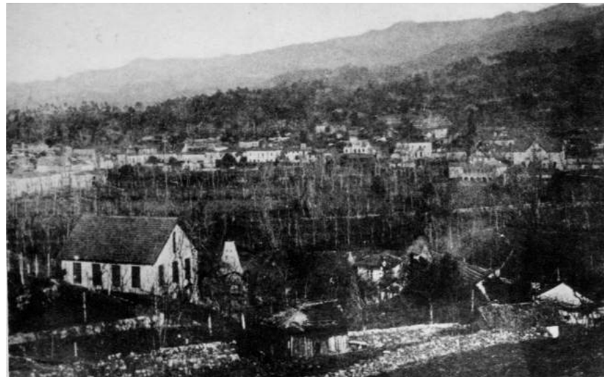
27 | Vista geral de Mondim de Basto Fonte: CMMB
